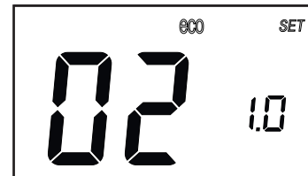
Рис. 12. Настройка отопительной кривой
